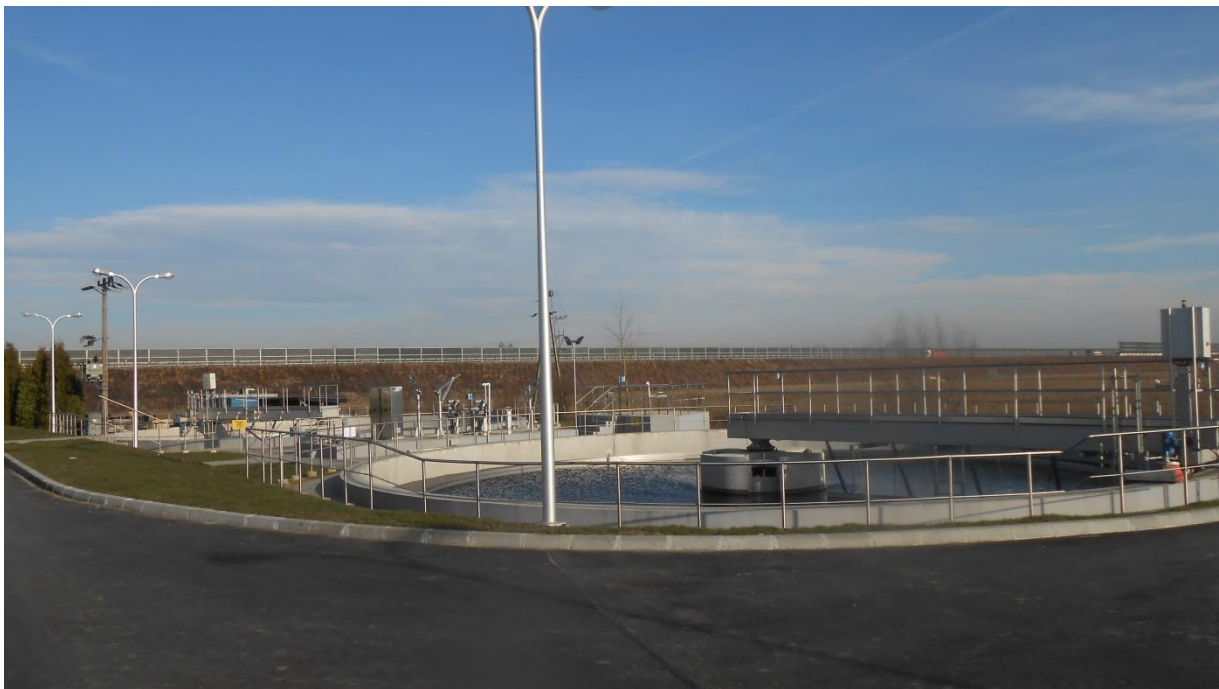
Rysunek 3. Oczyszczalnia ścieków w Nowej Wsi
